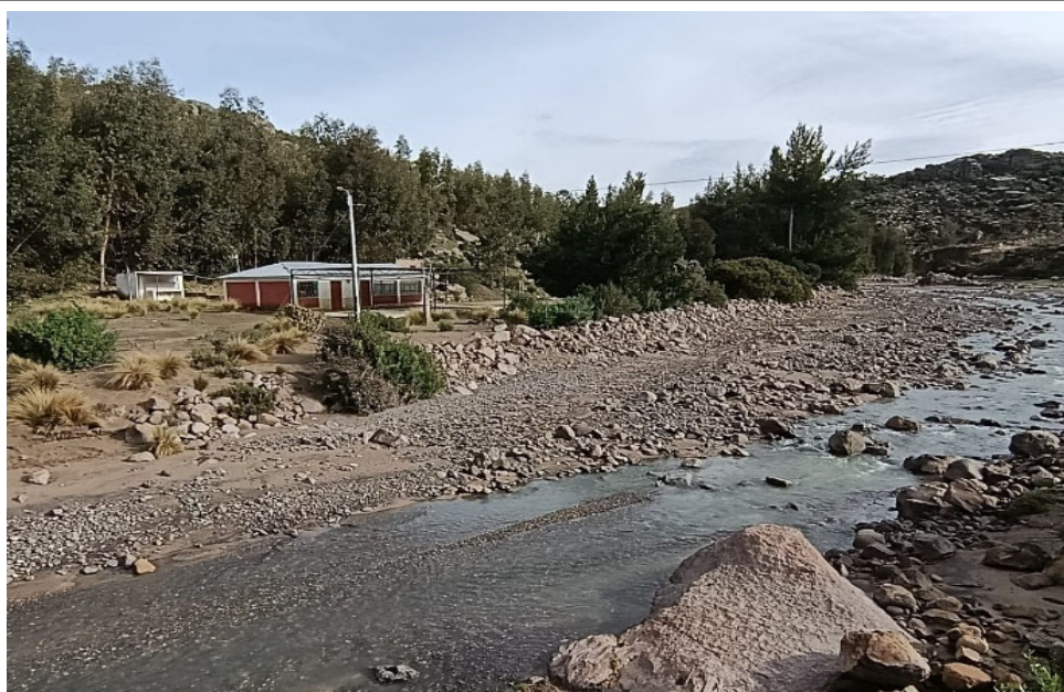
FIGURA N°03: Se observa la Institución Educativa en Escalerías, ubicada cerca del cauce de la quebrada. Durante precipitaciones intensas, el desborde provoca inundaciones y acumulación de lodo y piedras en sus instalaciones, como patio y losa deportiva.
