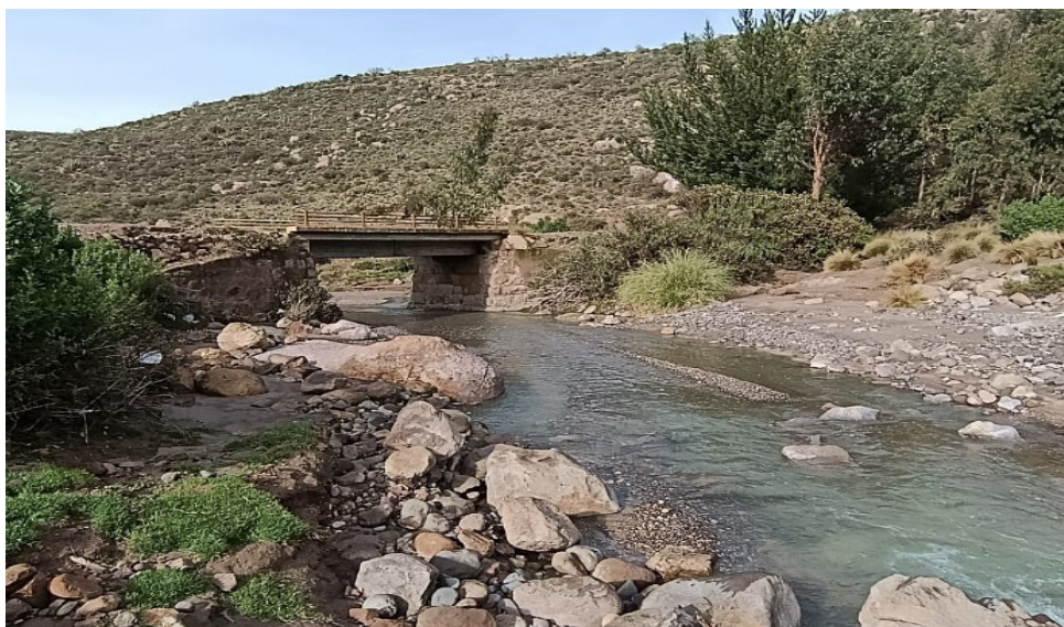
FIGURA N°04: Se observa el Puente Escalerías sobre la quebrada del mismo nombre. En épocas de lluvias intensas, el aumento del caudal provoca máximas avenidas, llegando el agua a sobrepasar la rasante del puente.
